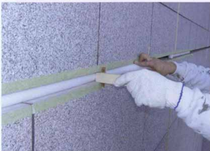
图 11 以小工具控制泡棉条到要求深度
