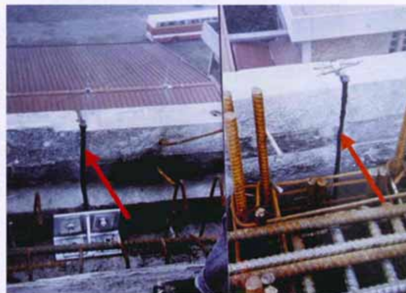
图 18 预制内侧需先填封密封胶才能现浇
