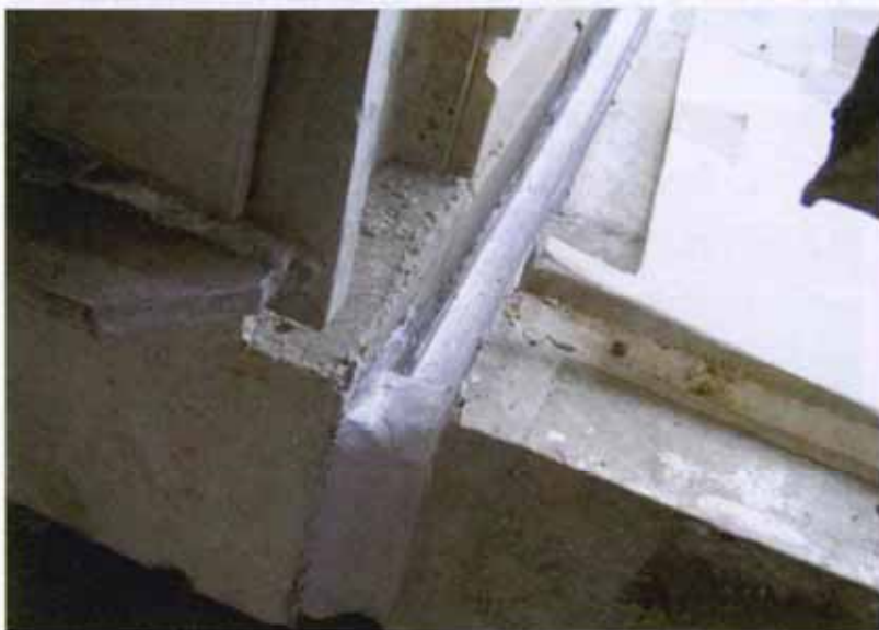
图 9 PC板四周断水填缝照片
