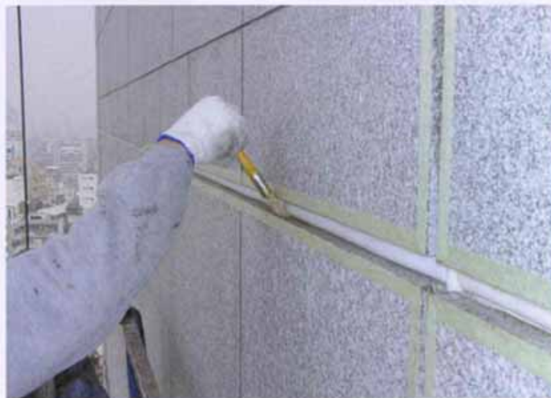
图 12 在需填缝两侧涂布底剂
