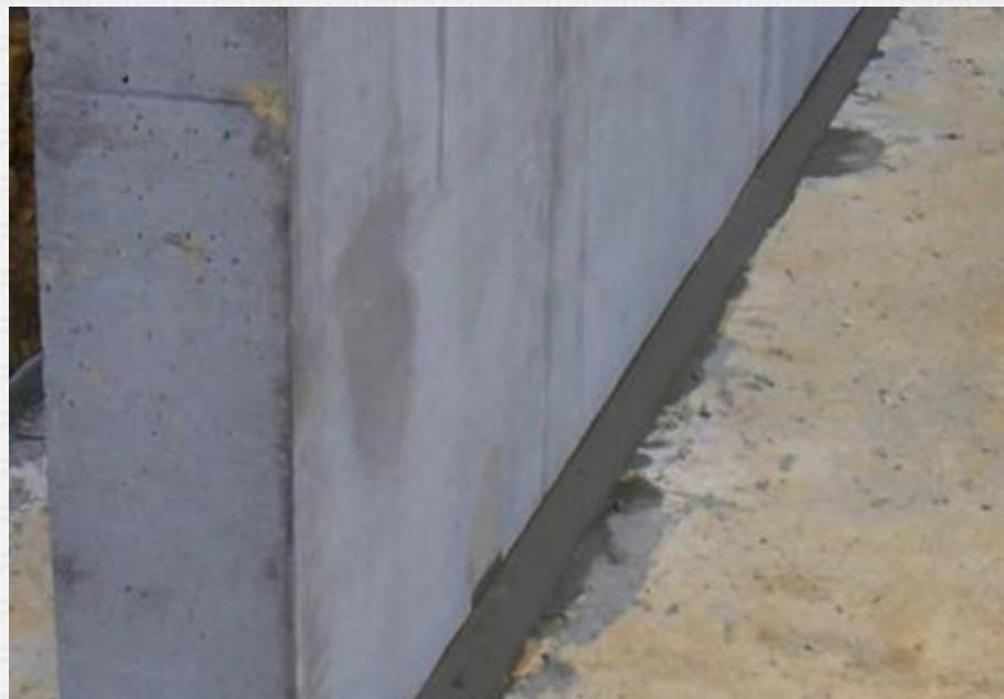
预制构件接缝塞缝
