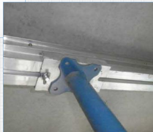
工字梁与支撑连接节点
