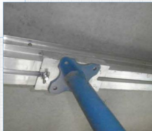
工字梁与支撑连接节点
