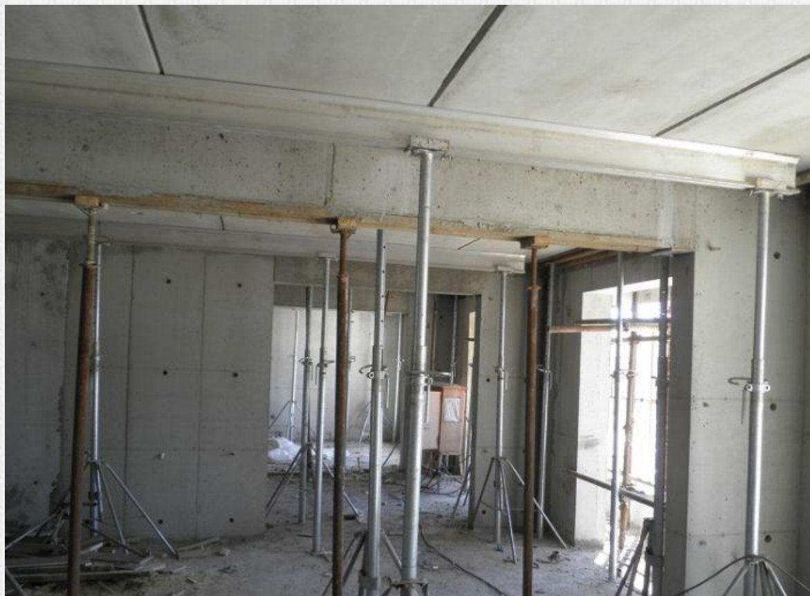
预制叠合楼板支撑体系搭设
