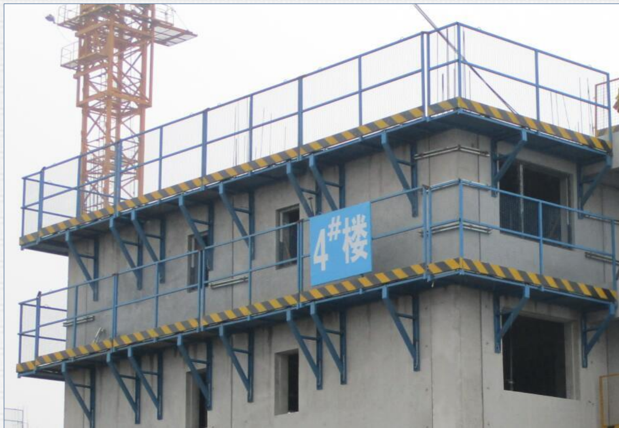
预制装配式结构可拆分式外挂架
