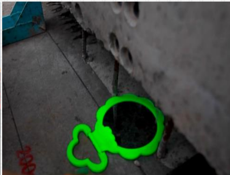
镜子观察墙板钢筋对孔情况
